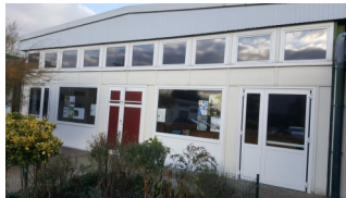
Nouvelles portes de sécurité
